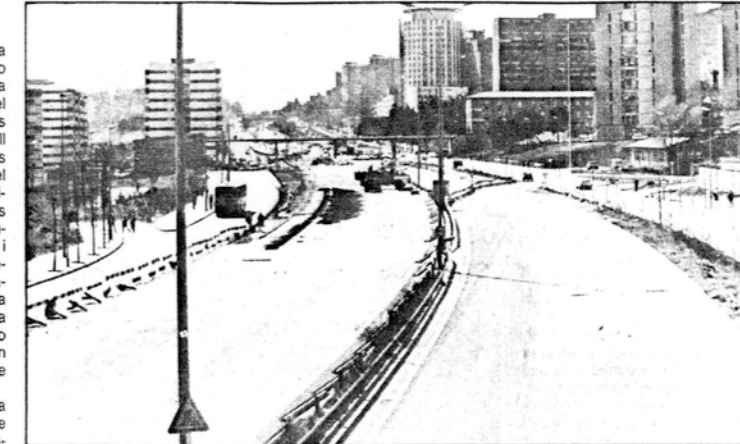
Obras del segundo cinturón a su paso por Vall d'Hebron.
